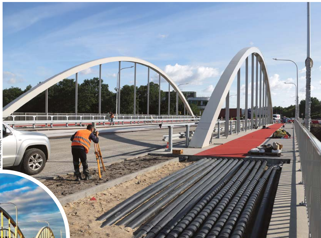
Trwają ostatnie prace przed planowanym otwarciem mostów 16 września
