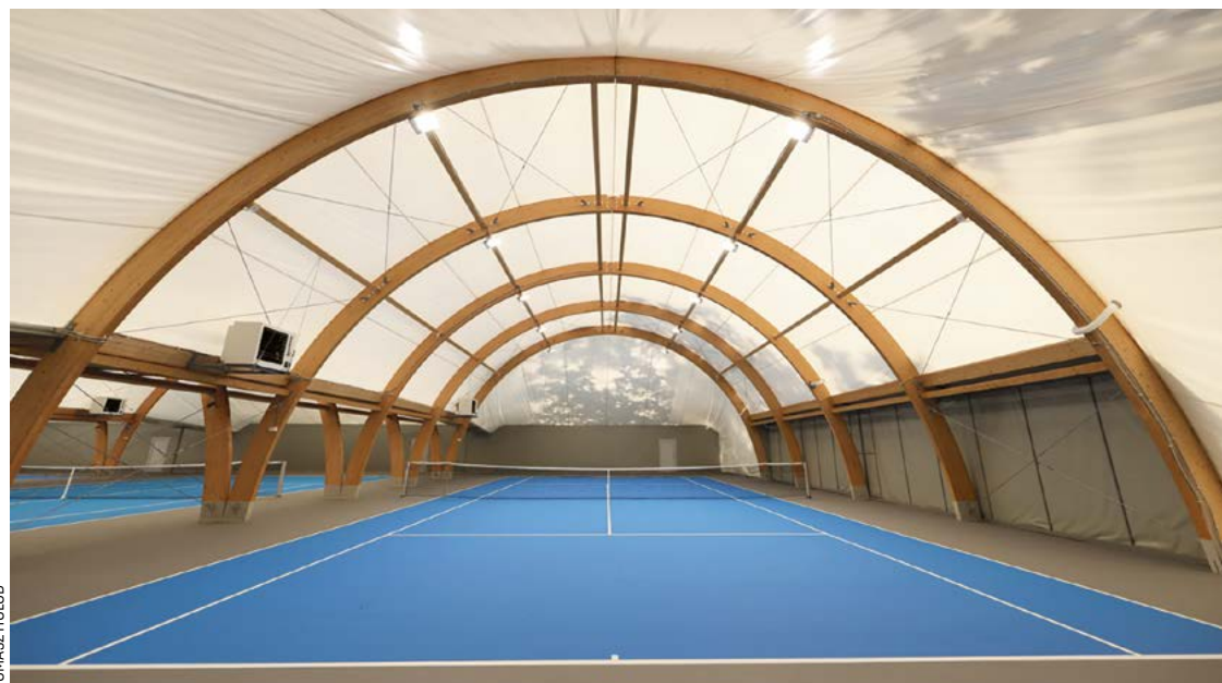
Konstrukcja hali jest drewniana. Jej dwie szczytowe ściany są otwierane, co przyda się wiosną i latem
